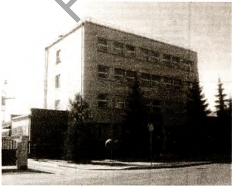
Пошта ў Лідзе, прыдні фасад
