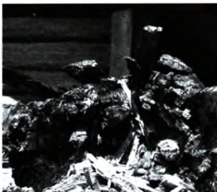
Фото 1. Разрушение основания опорного столба *S. lacrymans*.
